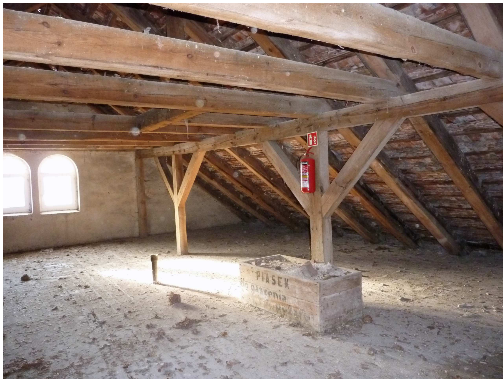
Fragment więźby dachu nr 2.
