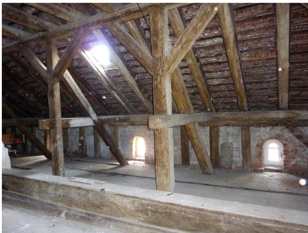
Fragment więźby dachu nr 1.
